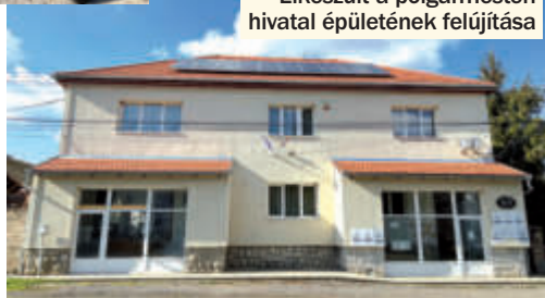
Elkészült a polgármesteri hivatal épületének felújítása
